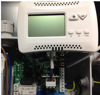
Collegamento T-MB morsetti n° 5, 6, 7
